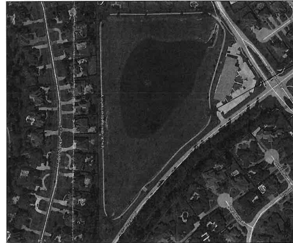
OAKMONT PUD - WEST DETENTION
